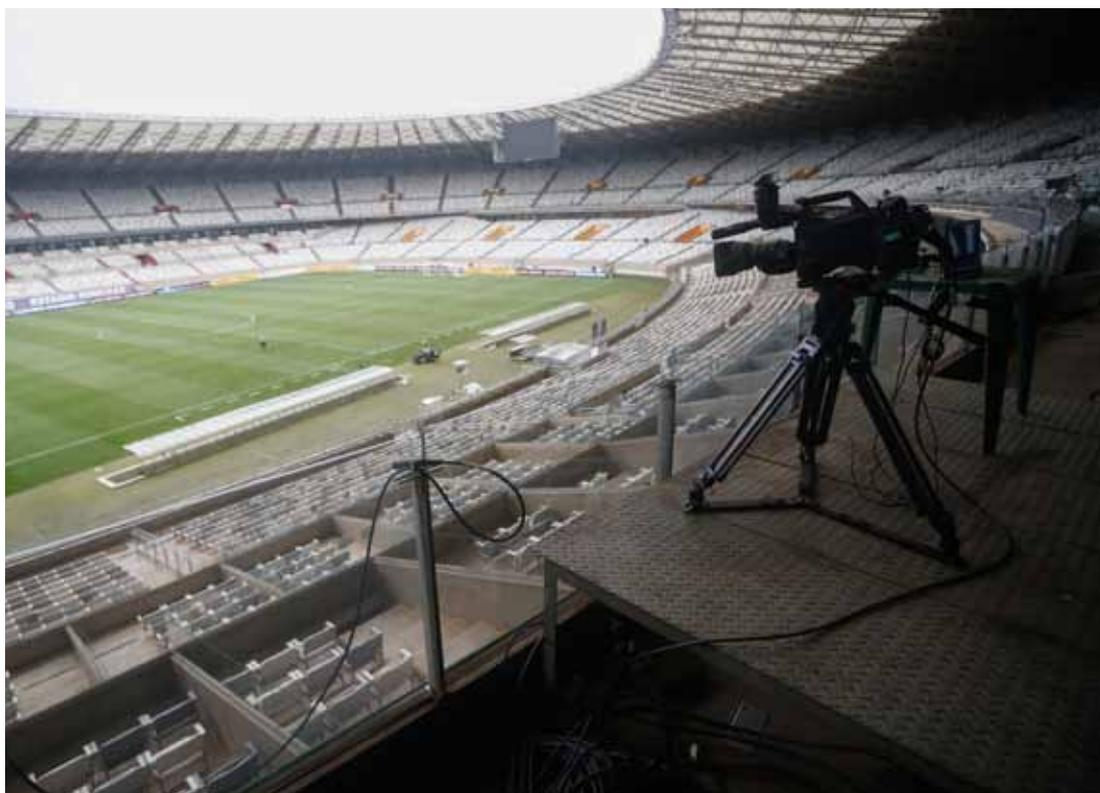
**Câmeras da linha de impedimento (5 e 6):** Duas câmeras instaladas exatamente nas linhas de 18 jardas, no mesmo nível ou mais alto que a plataforma da câmera principal.
